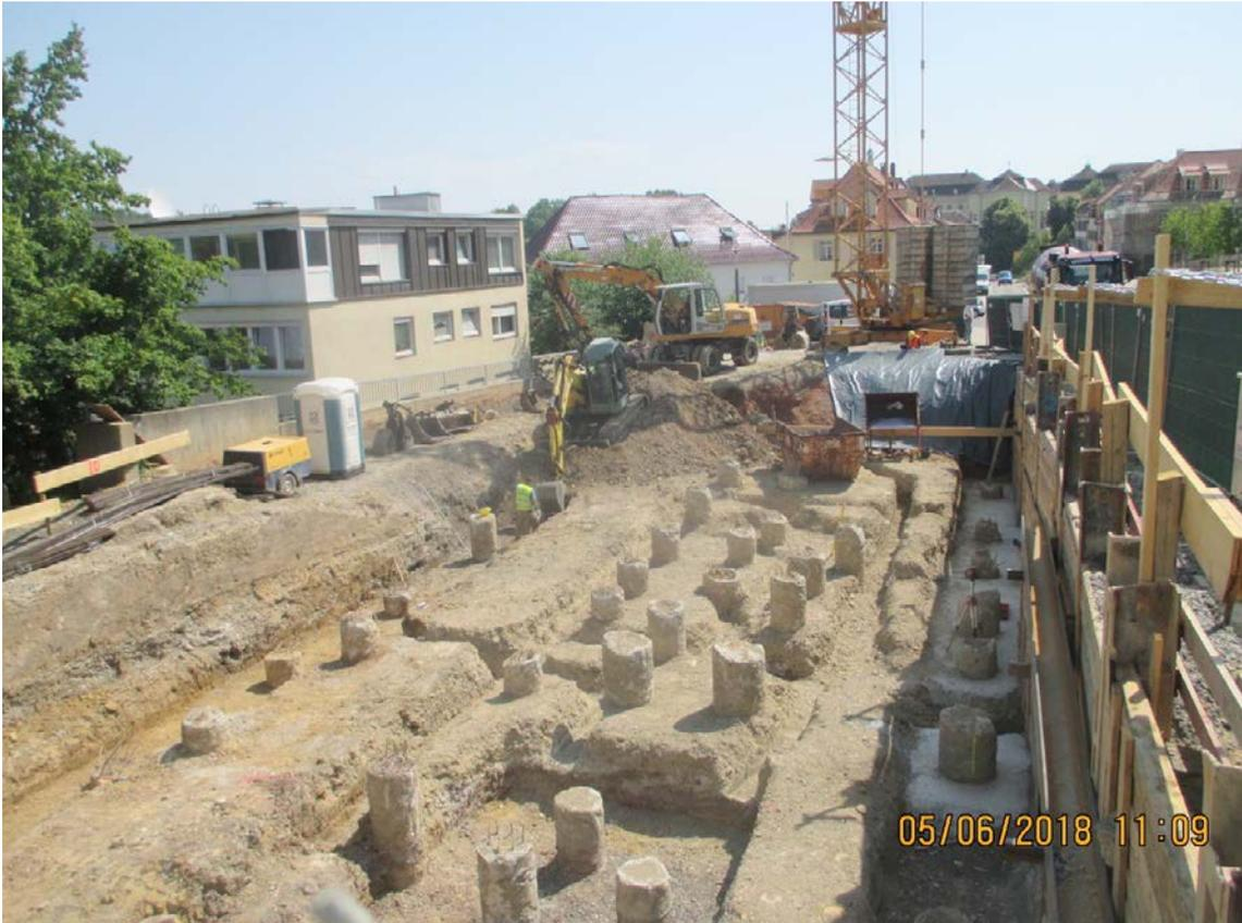
BILD 3: AUSGEHOBENE BAUGRUBE MIT FREIGELEGTEN BOHRPALKÖPFEN
