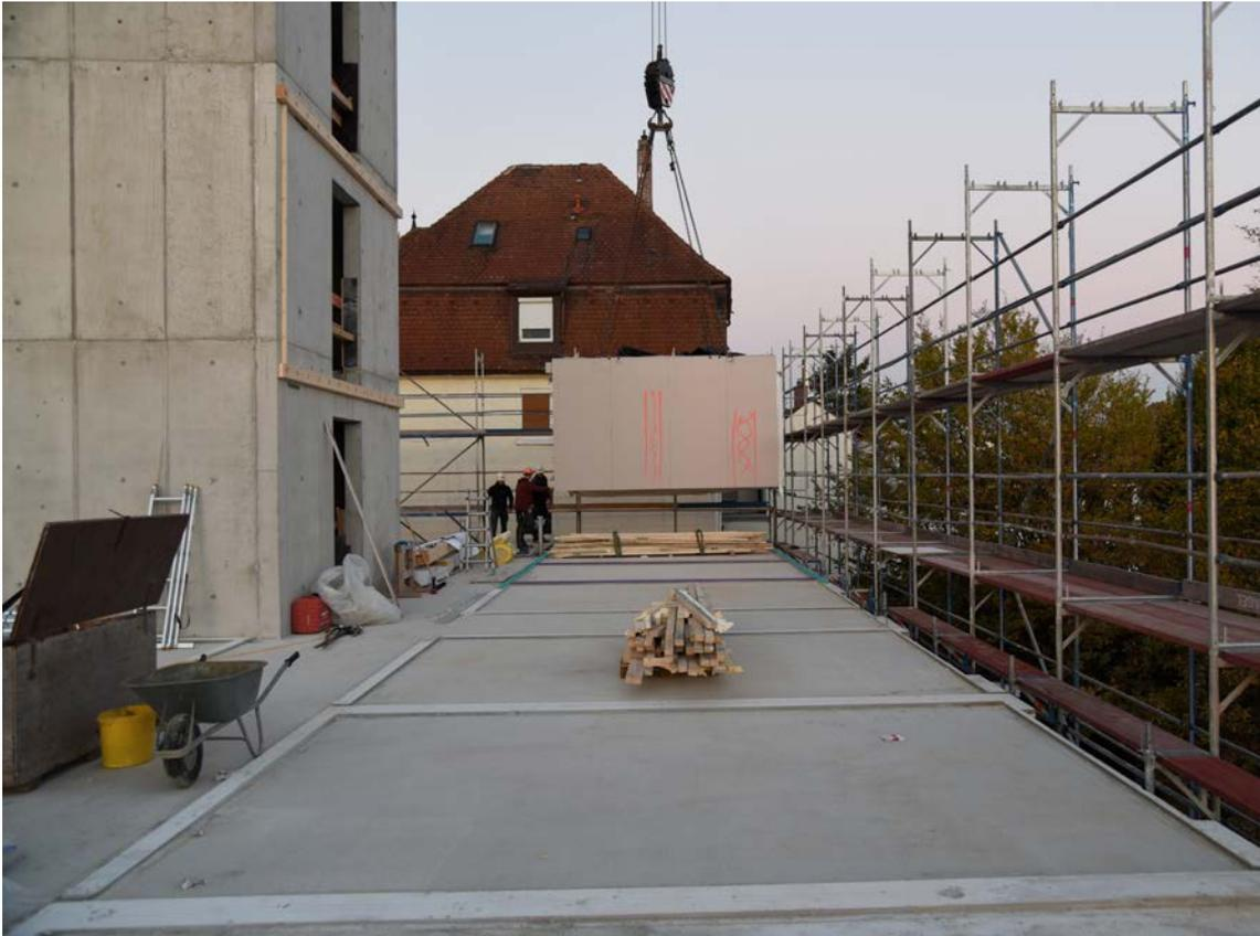
BILD 15: 22.10.2018 - MONTAGEBEGINN, ABSETZEN DES ERSTEN MODULS
