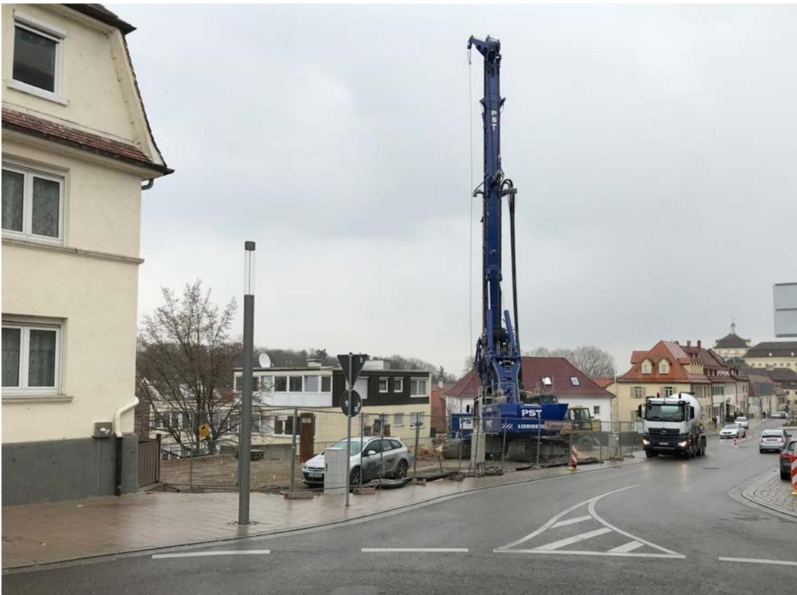
BILD 2: BEGINN DER BOHRPFahl- UND VERBAUARBEITEN
