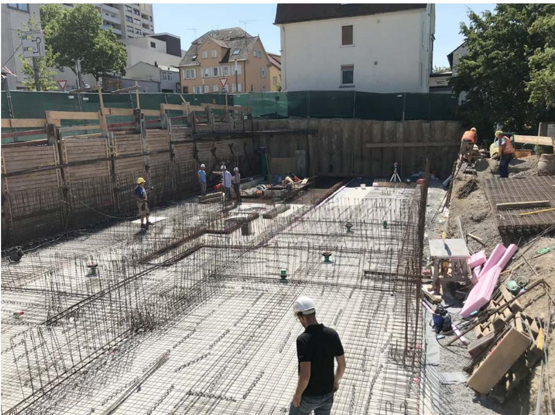
BILD 4: BODENPLATTE KURZ VOR DER BETONAGE
