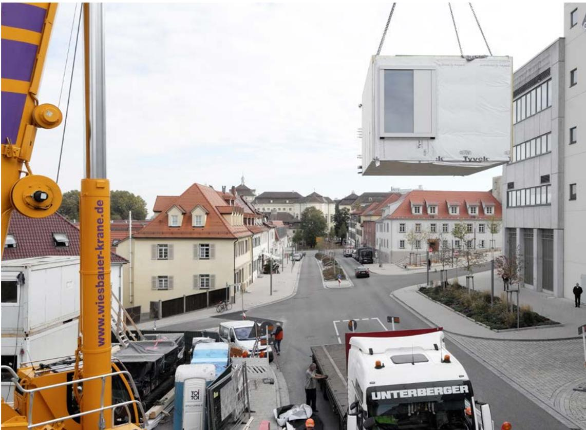
BILD 16: 22.10.2018 - VERSETZEN RAUMMODUL
