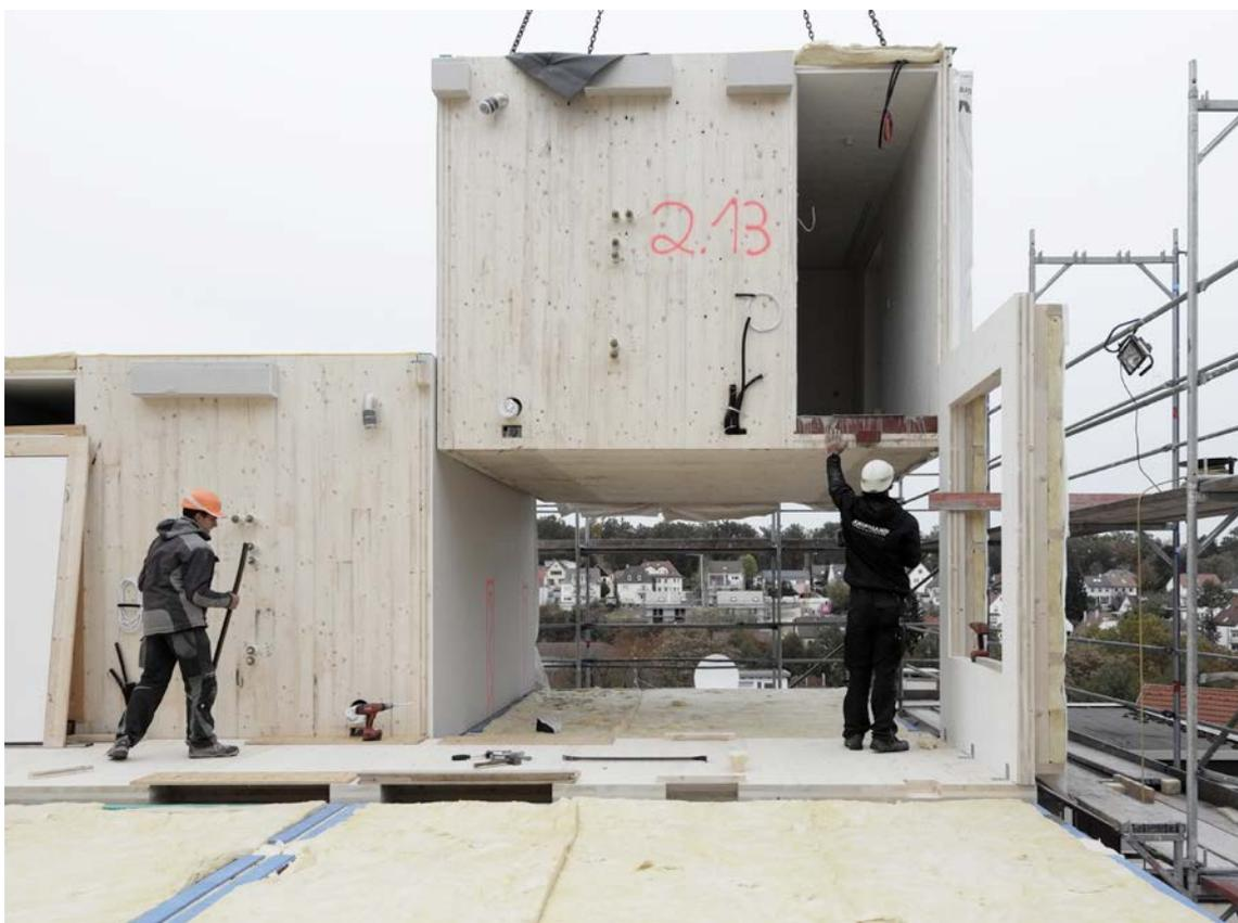
BILD 18: 22.10.2018 - VERSETZEN RAUMMODUL
